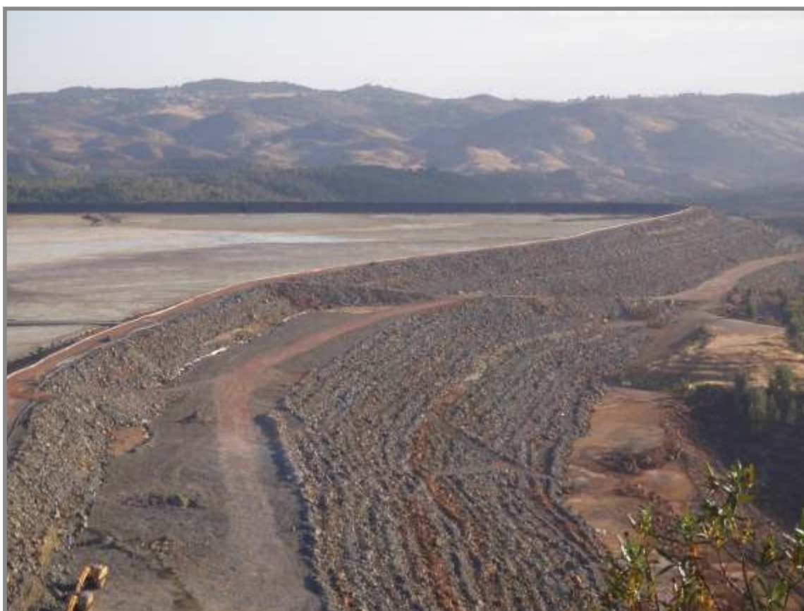
Figura 6. Por lo general, los estériles de planta se almacenan permanentemente sobre el terreno detrás de una presa de estériles de planta construida con residuos mineros. La foto de la presa Aguzadera en la mina de cobre Riotinto de Atalaya Mining fue tomada por el autor el 19 de junio de 2019. Aunque el Estudio de Impacto Ambiental (EIA) enumera las presas de estériles de planta en la mina de Riotinto como ejemplos de presas de estériles de planta con “riesgo cero” (CRS Ingeniería, 2023a), un informe anterior del autor evaluó la probabilidad anual de falla de las presas de estériles de planta en la mina Riotinto en un 15% (Emerman, 2019).
