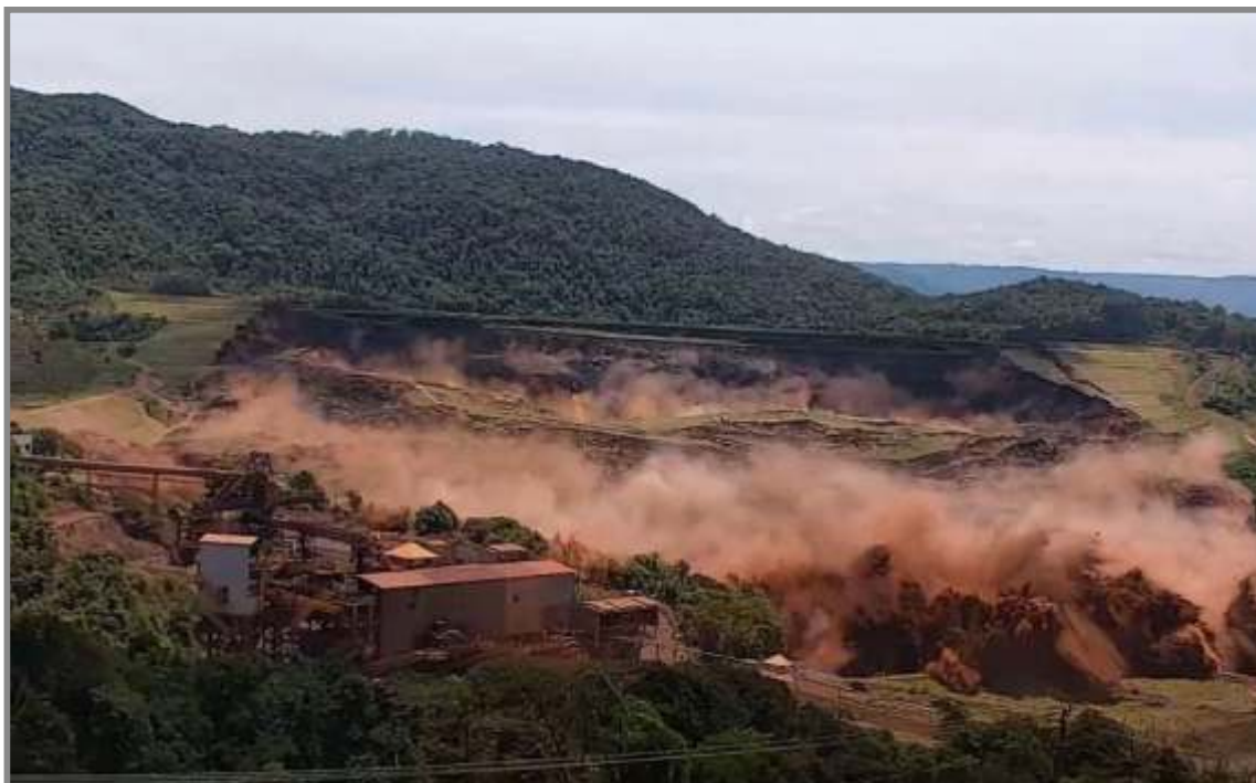
Figura 10. El 25 de enero de 2019, la falla de una presa de estériles de planta en la mina Córrego do Feijão , cerca de Brumadinho , Brasil , provocó la muerte de 270 personas, incluidas las de 258 trabajadores mineros. La falla condujo a la publicación del Estándar Global de Gestión de Relaves para la Industria Minera en agosto de 2020 (ICMM-UNEP-PRI, 2020). Foto de Robertson et al. (2019).
