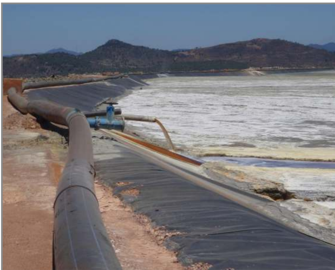
Figura 7a. Una mezcla de agua y estériles de planta con un contenido de sólidos del 35% en masa se descarga hidráulicamente en el estanque de estériles de planta desde la cresta de la presa Cobre en la mina Riotinto de Atalaya Mining en Andalucía, España (ver Fig. 6). Foto tomada por el autor el 21 de junio de 2019.
