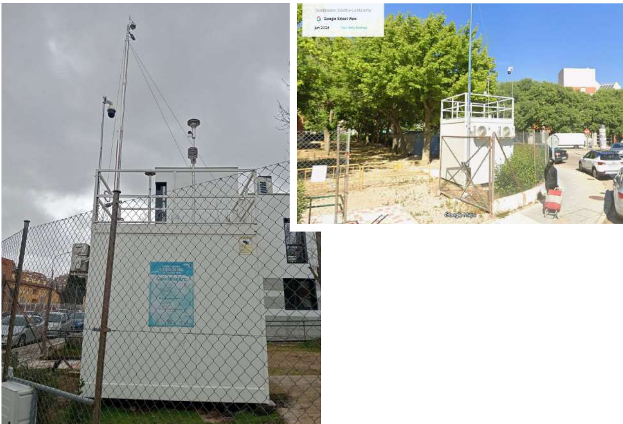
Fotografía 11. Estación de medición de Guadalajara.
