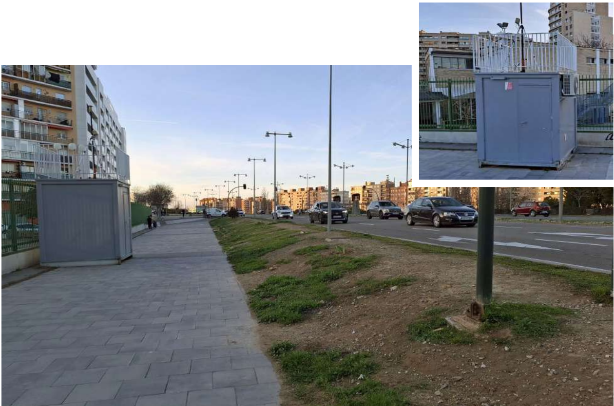
Fotografía 25. Estación de medición de Zaragoza (Avenida Soria).
